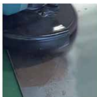
Polimento em superfície oxidada
