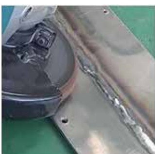
Limpeza em cordões de soldadura
